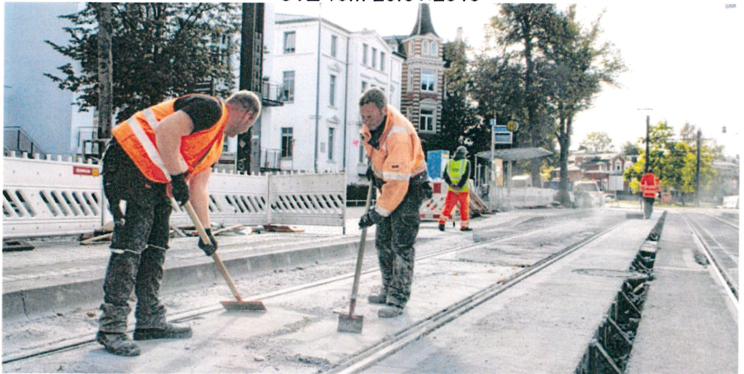
Restarbeiten auf der Trasse stadteinwärts: Mitarbeiter der Firma Matthäi beseitigen kleine Unebenheiten und Betonreste.
