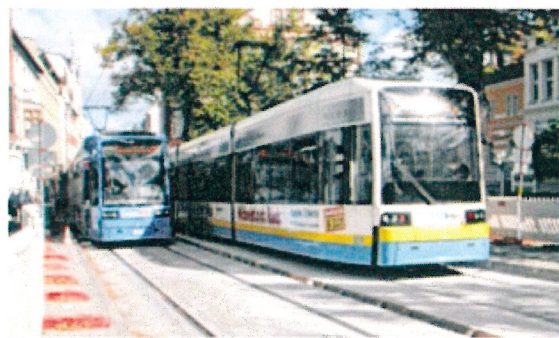
Vorsichtig fahren die Straßenbahnen durch den Baustellen-Bereich.
