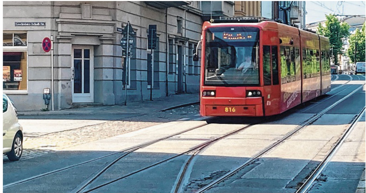
In diesem Bereich der Goethestraße werden zwei Weichen entfernt.
