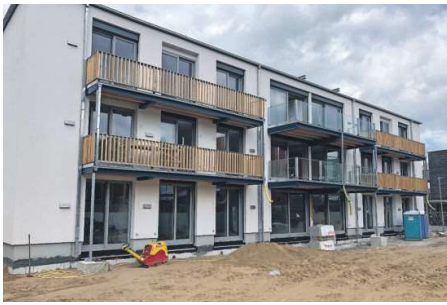
Die Baumaßnahmen für das Seniorenwohnen auf dem Gelände der Alten Brauerei gehen dem Ende zu. Foto: Kohler
